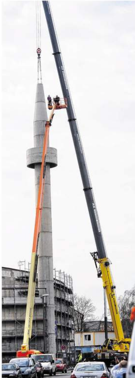
Gestern wurde die neun Meter hohe Spitze auf das nun 40 Meter lange Minarett der neuen Yunus-Emre-Moschee gesetzt. Foto: Harald Krömer
